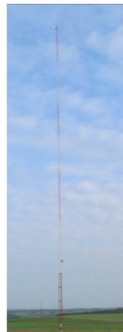
Exemple d'un mât de mesure
